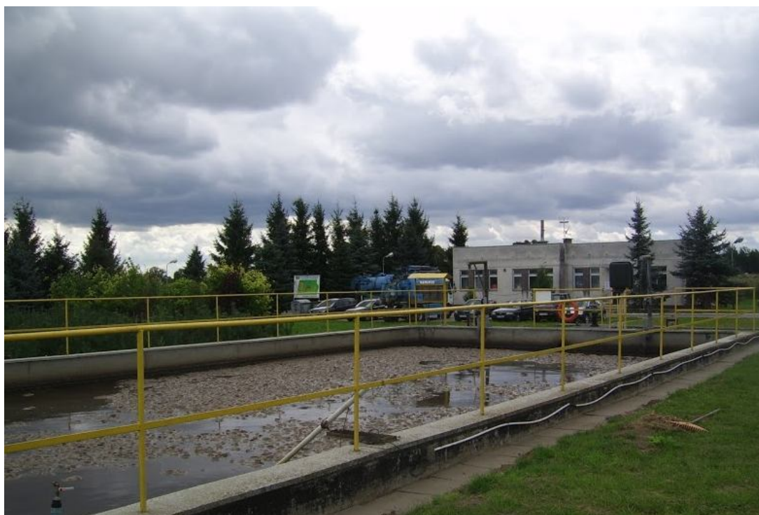
Zdjęcie nr 14. Komora osadu czynnego nr 3.
