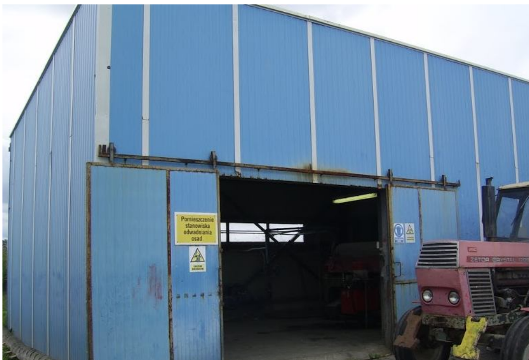
Zdjęcie nr 10. Budynek odwadniania osadu nadmiernego.
