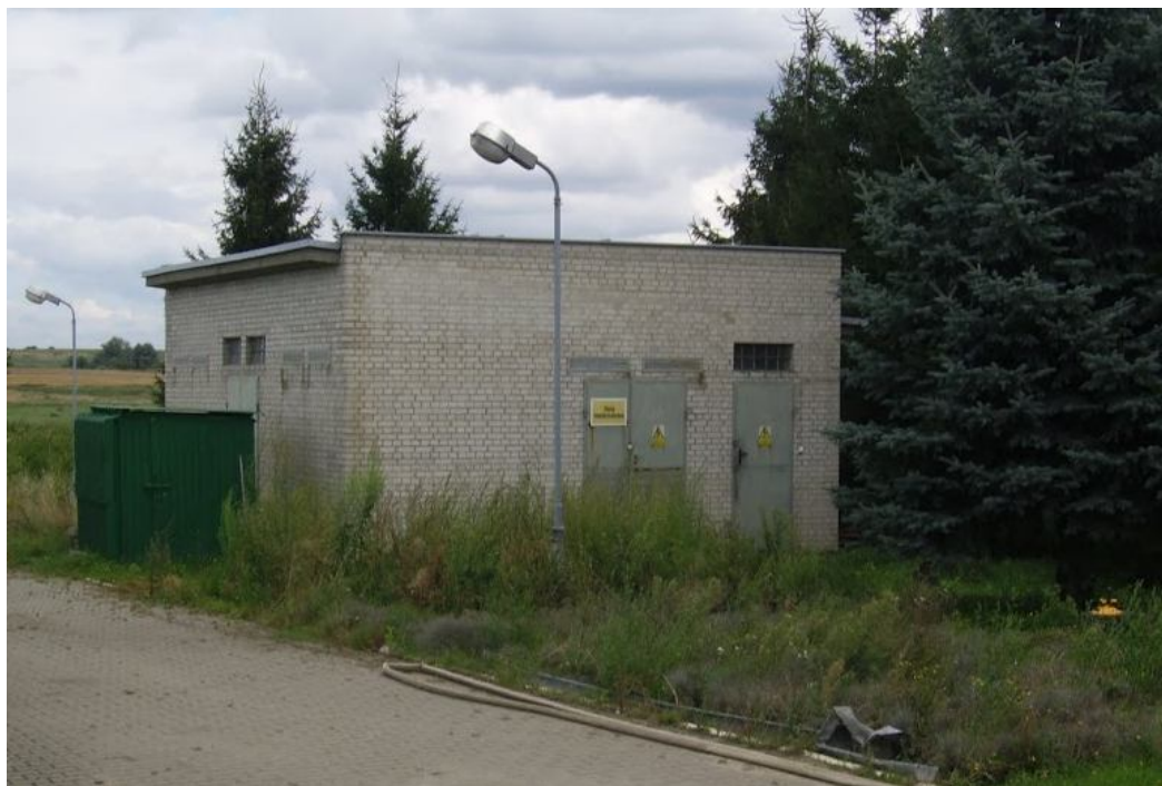
Zdjęcie nr 12. Stacja transformatorowa.
