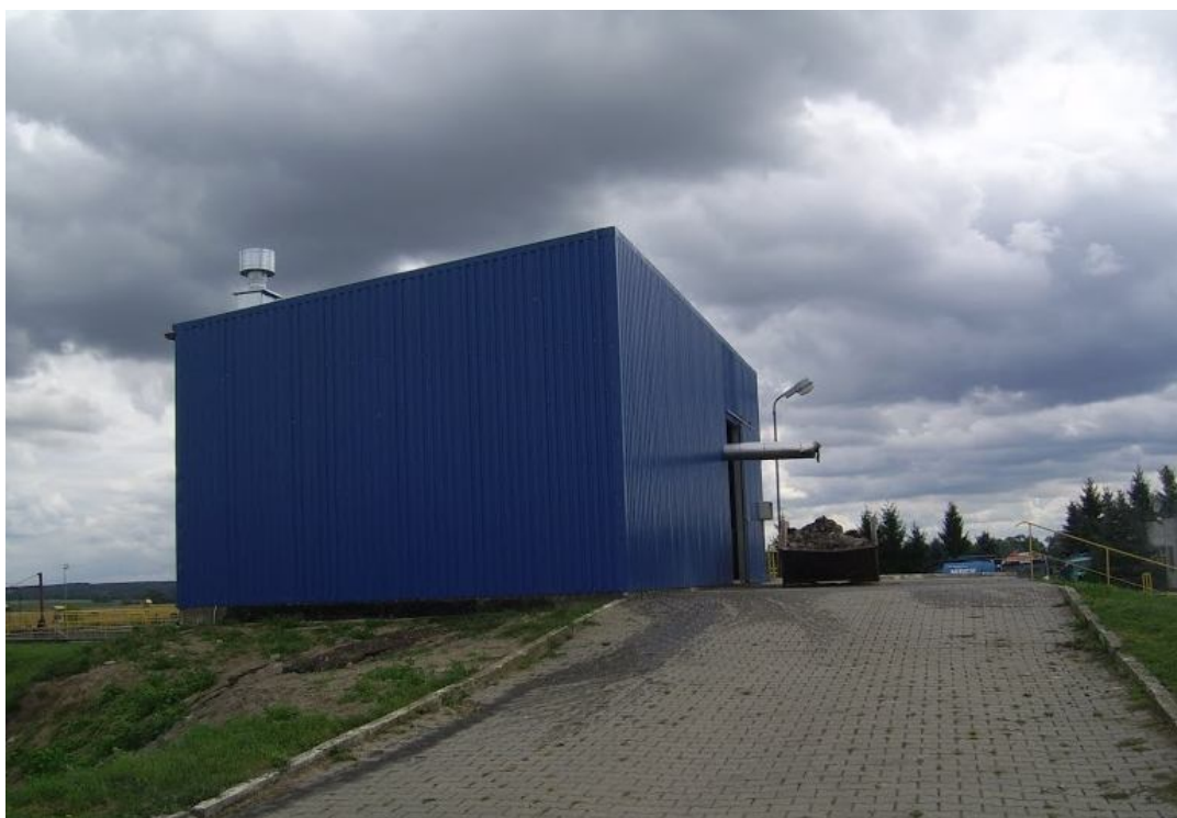
Zdjęcie nr 1. Budynek komory rozprężnej, kraty mechanicznej i prasy skratek.
