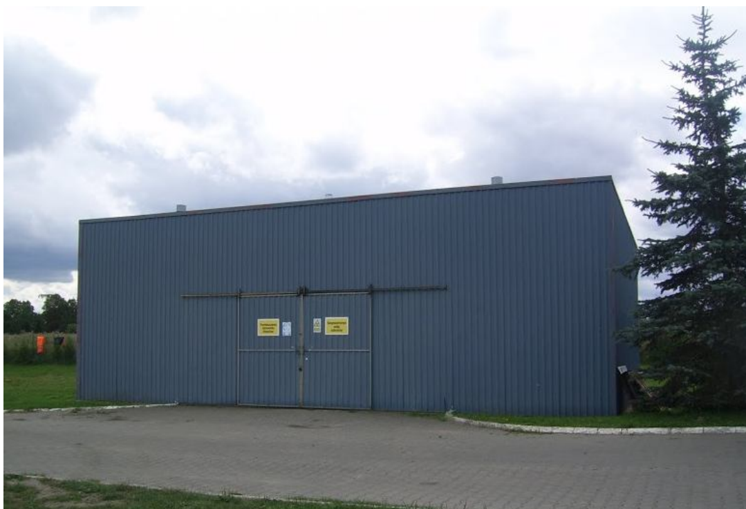
Zdjęcie nr 9. Budynek dmuchaw.
