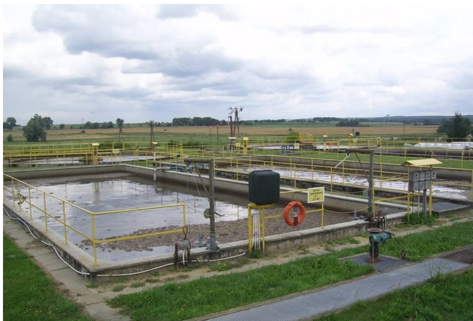
Zdjęcie nr 16. Komora osadu czynnego nr 1.
